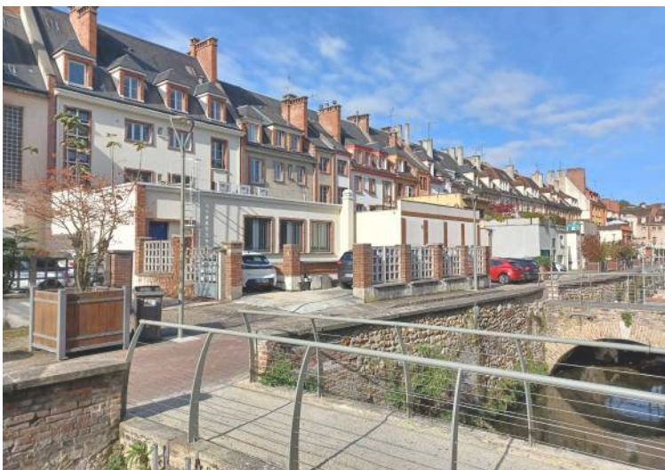
L'Iton, les garages et l'arrière des boutiques de la rue Chartraine
